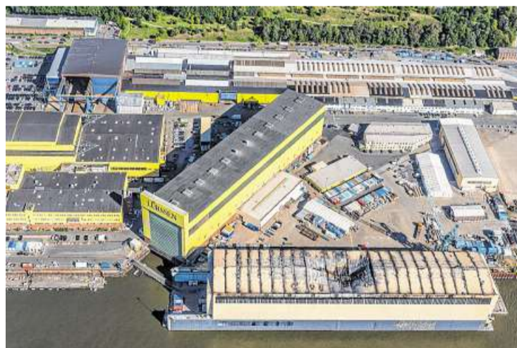
Die Halle an der Weser nach dem Brand: In der Mitte ist das eingestürzte Dach zu erkennen. Mehr als 900 Feuerwehrleute waren hier im Einsatz. FOTO: DETMAR SCHMOLL/STUDIO B
